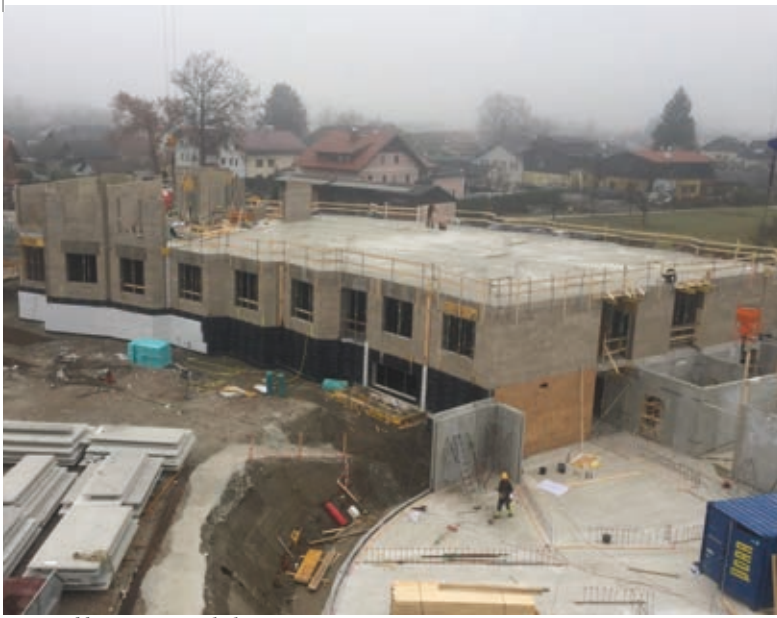
Bilder: Seniorenwohnheim in Bau
