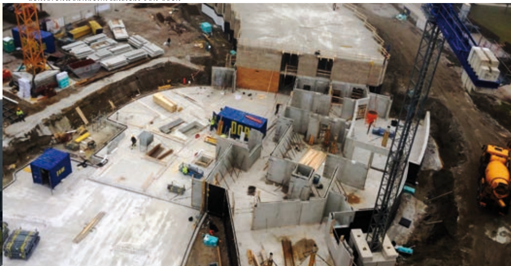
Seniorenwohnheim Ansicht von oben
